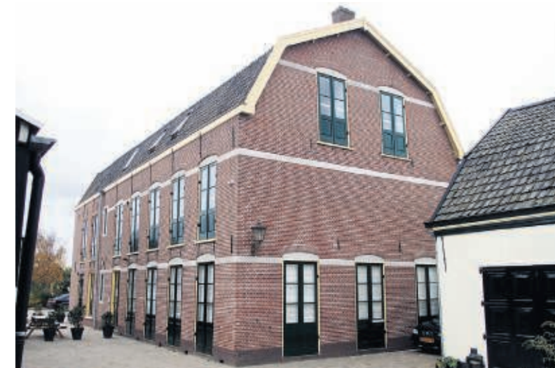
De eigenaar van de voormalige bollenschuur aan de Zuider Leidsevaart 2B in Hillegom kreeg op 11 december de Zwarte Tulp Prijs voor de renovatie van zijn rijksmonument. beeld Jos van Rooden
