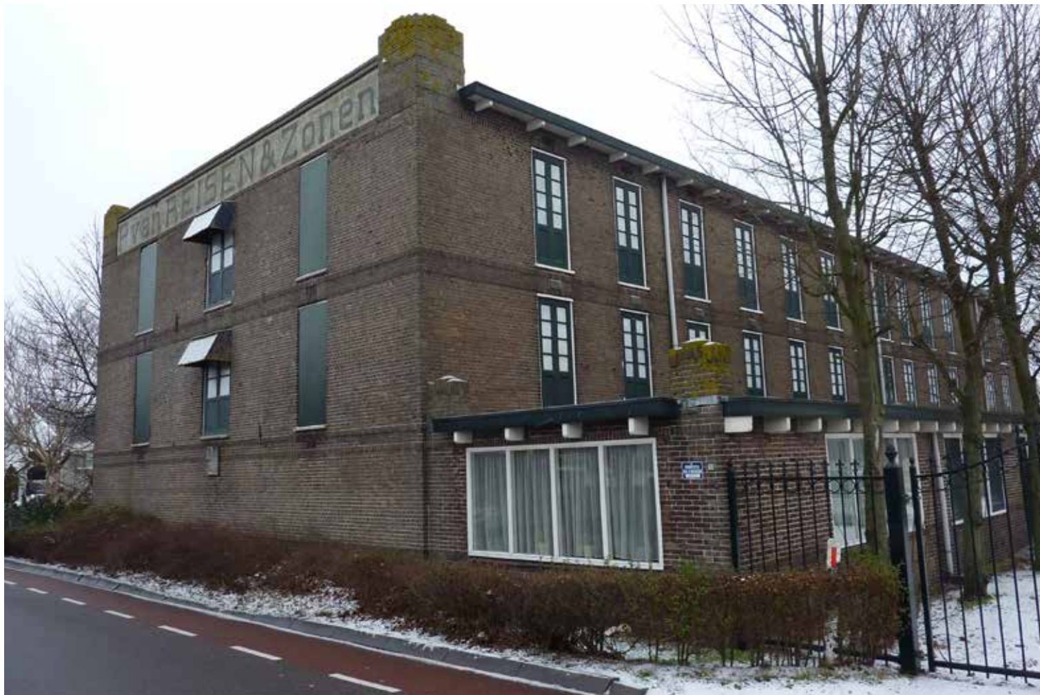
BOLLENSCHUUR MET HOUTEN VENTILATIEDEUREN, EEN RIJKSMONUMENT IN VOORHOUT (FOTO JOS WARMENHOVEN).
